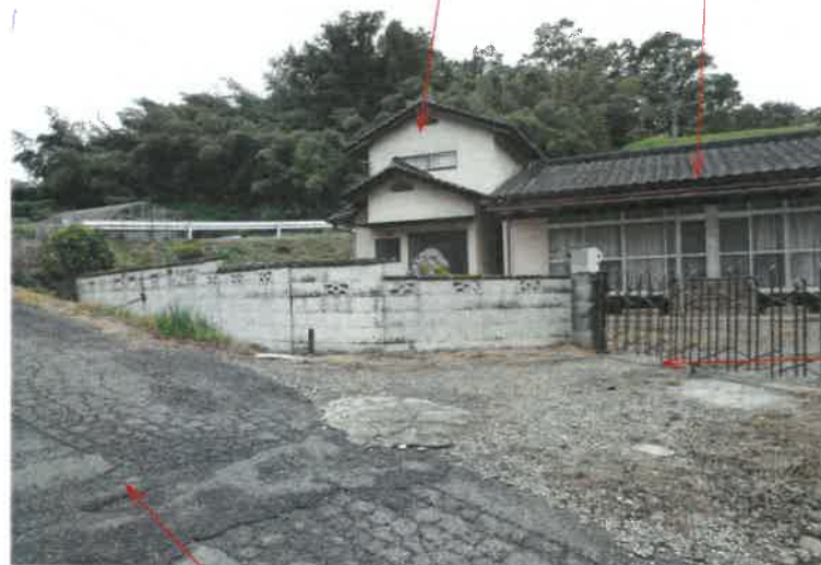
写真2 物件1 件外建物主である建物 目的外土地
