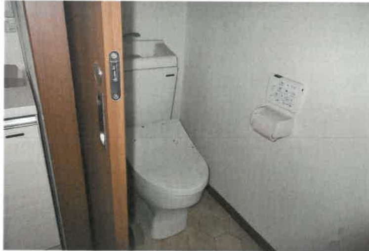
写真10 主建物・2階トイレ
