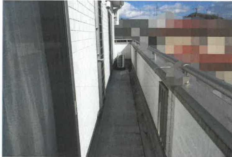
写真16 主建物・2階バルコニー
