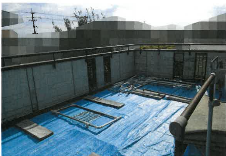
写真 2 4 2 階バルコニー
