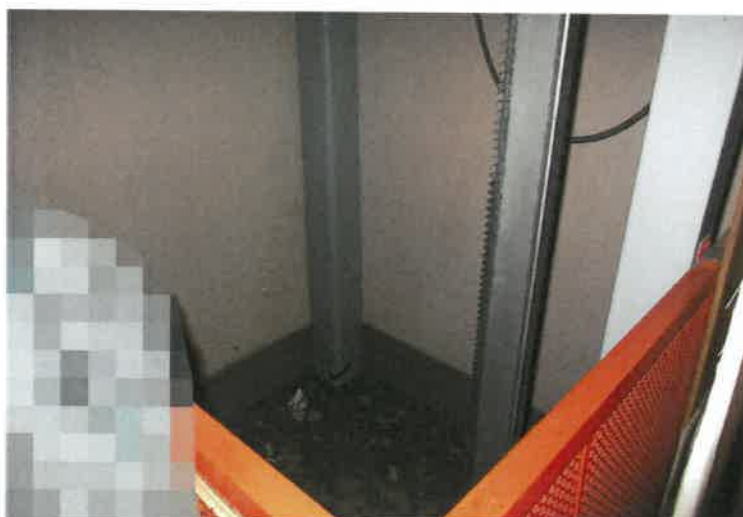
写真12 1階作業場（リフト）
