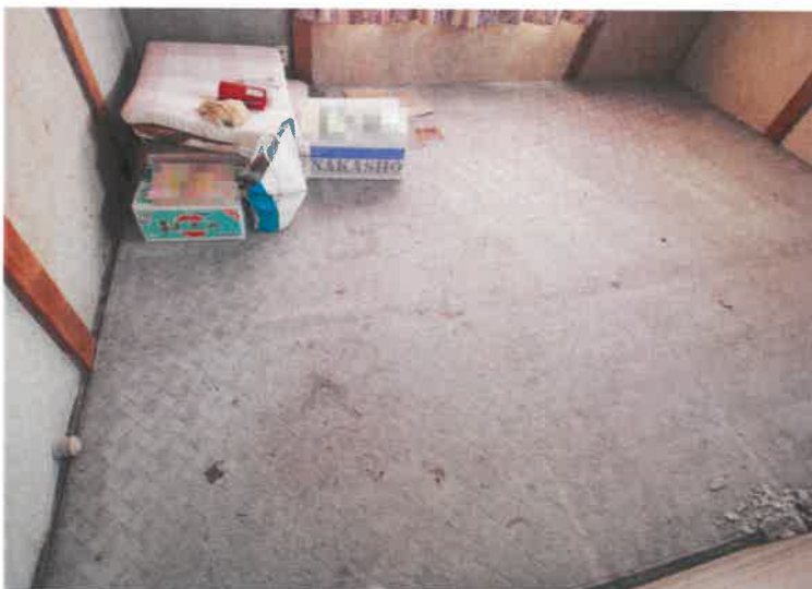
写真9（主建物2階南側和室6帖）
