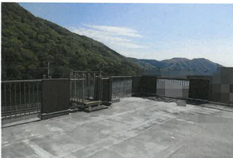
写真18 屋上バルコニー
