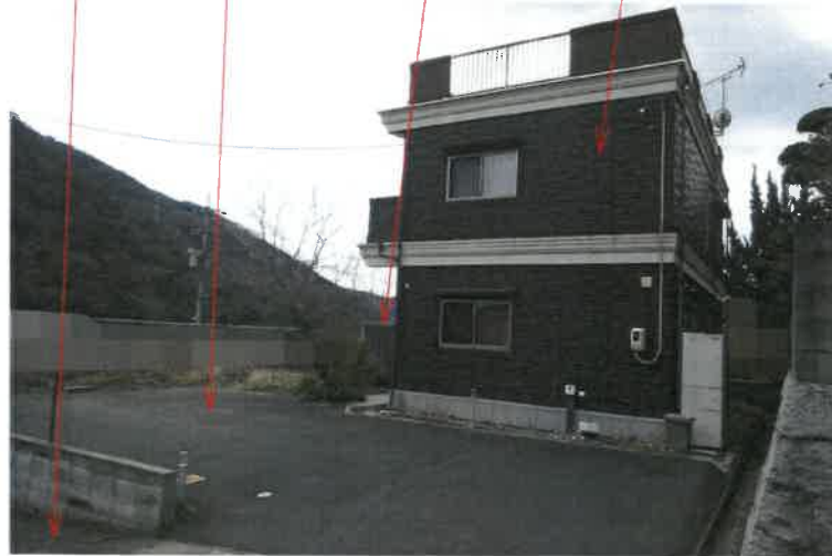
写真2 市道 物件1土地 簡易物置 物件2建物
