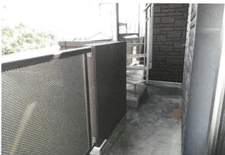
写真17 2階バルコニー
