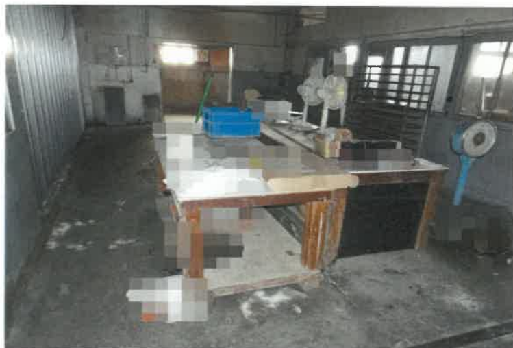
写真4 3 物件1 7の建物内の状況
