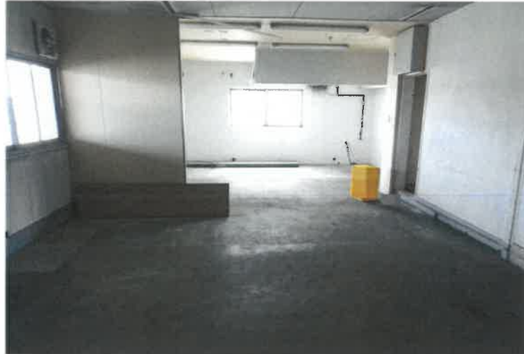
写真 4 9 物件 1 7 の建物内の状況
