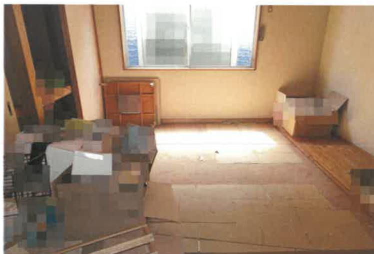
写真 6 4 物件 2 0 の建物内の状況
