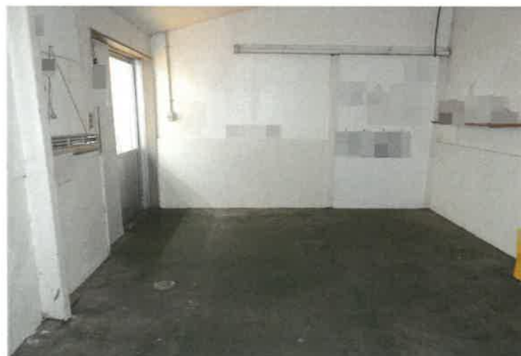
写真 3 9 物件 1 7 の建物内の状況
