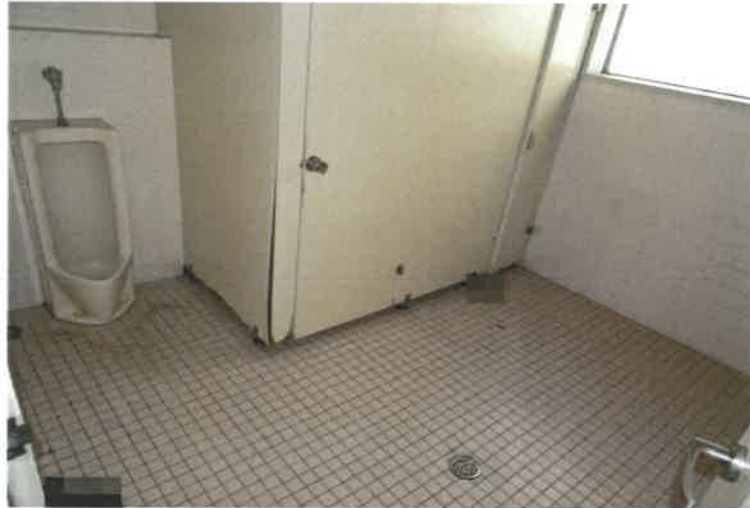
写真 6 1 物件 2 0 の建物内の状況
