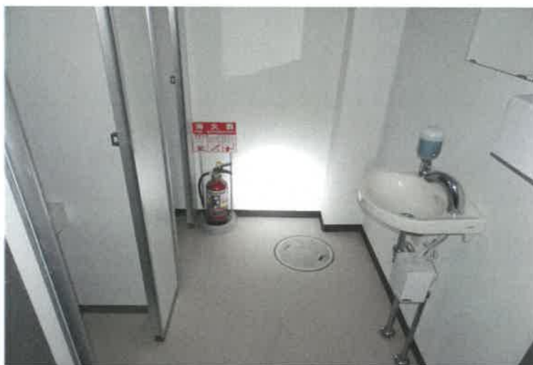
写真 2 0 物件 1 6 の建物内の状況
