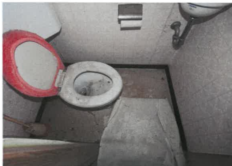
写真1 5 (物件9建物B室1階トイレ)
