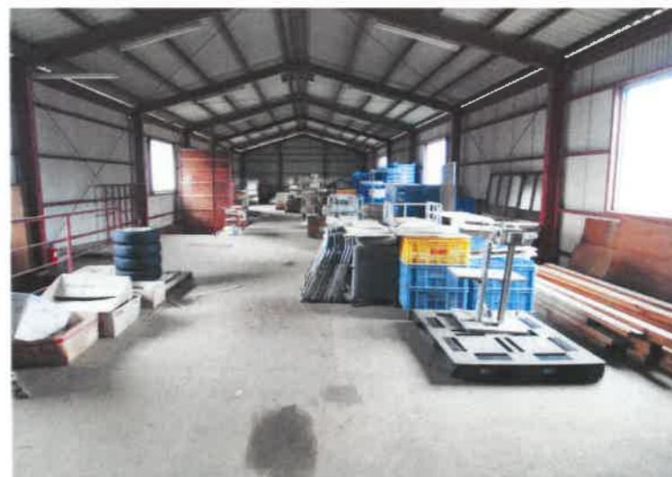
写真9 (物件4主建物2階倉庫)
