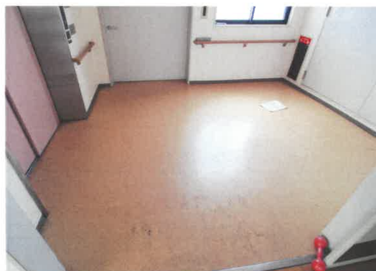
写真 2 4 （3階エレベーターホール）
