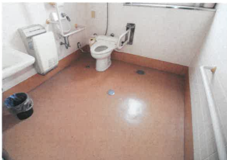
写真21 (2階身障トイレ)
