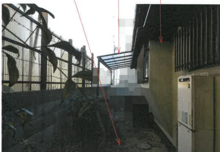
写真5 物件1土地 下屋 物件2建物
