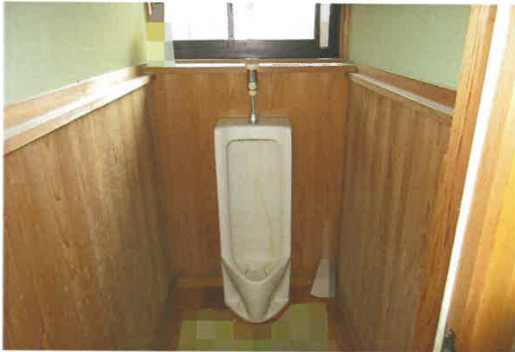
写真8 物件3主建物・1階男子トイレ（使用禁止）
