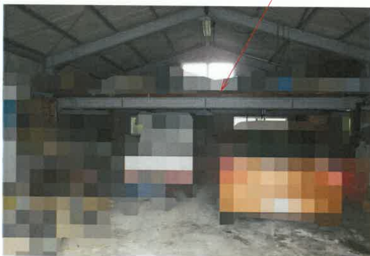
写真3 2 物件4建物・車庫・物置 中2階
