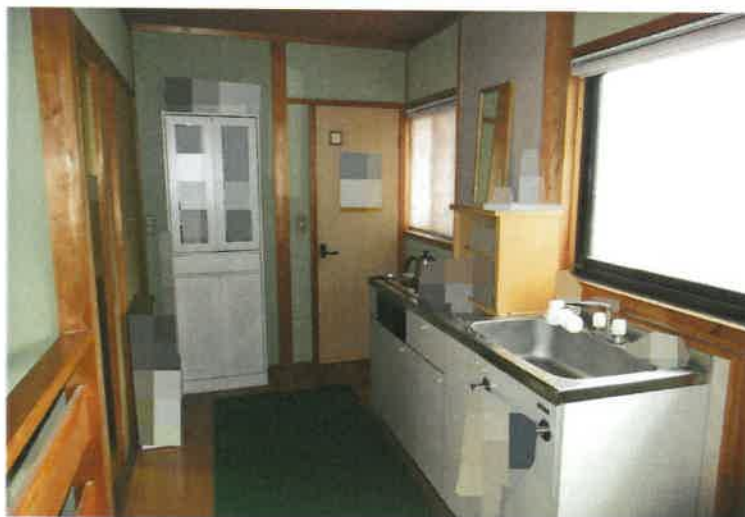
写真21 物件3主建物・2階簡易キッチン部分
