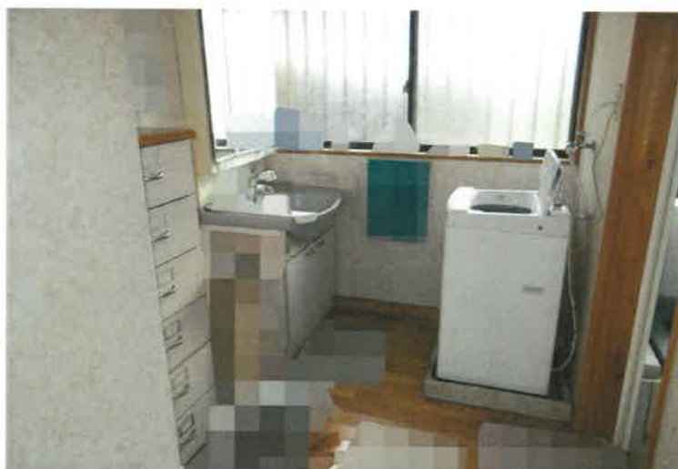
写真11 物件3主建物・1階洗面所
