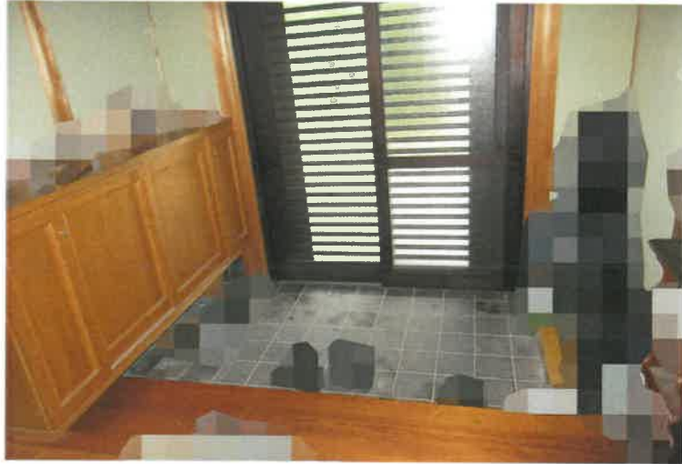
写真7 物件3主建物・1階玄関
