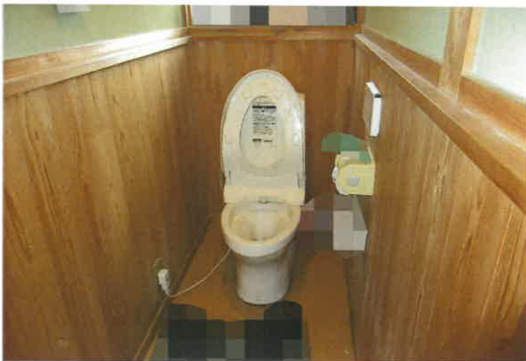
写真9 物件3主建物・1階トイレ
