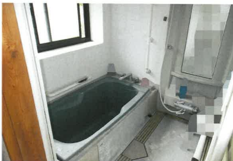
写真12 物件3主建物・1階浴室
