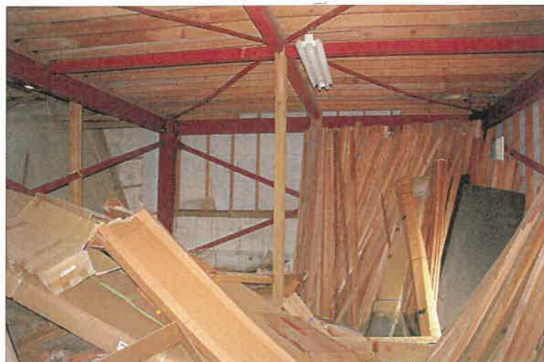
倉庫（未登記増築箇所）
