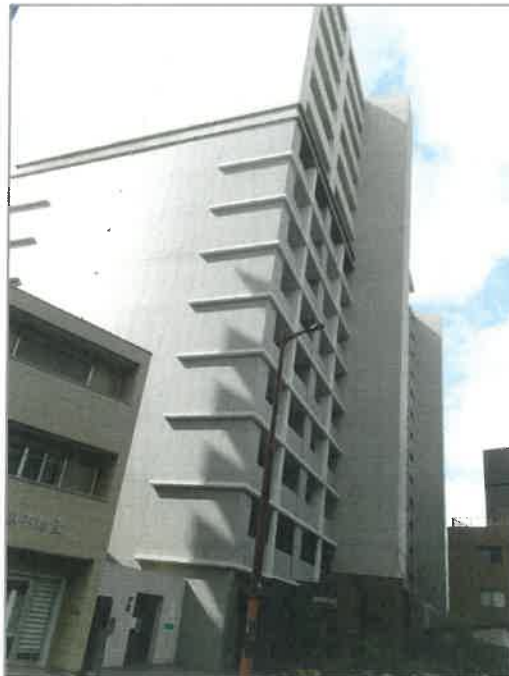
1 目的物件のある 一棟の建物の外観
