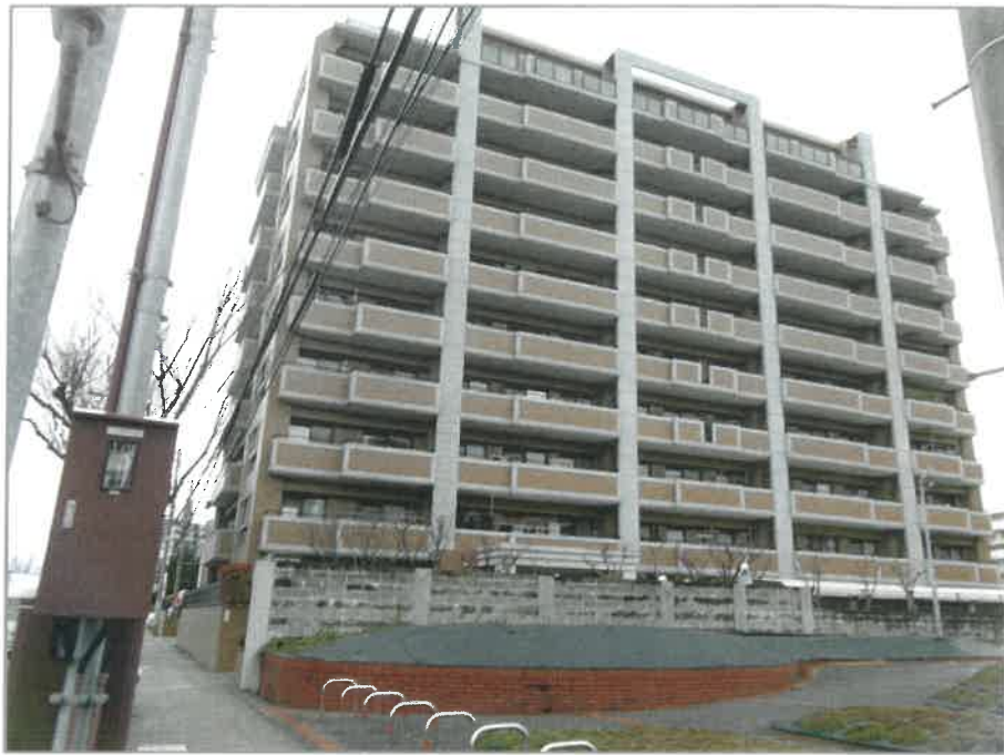
1 目的物件のある 一棟の建物の外観
