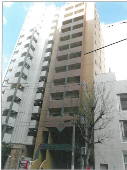
1 目的物件のある 一棟の建物の外観
