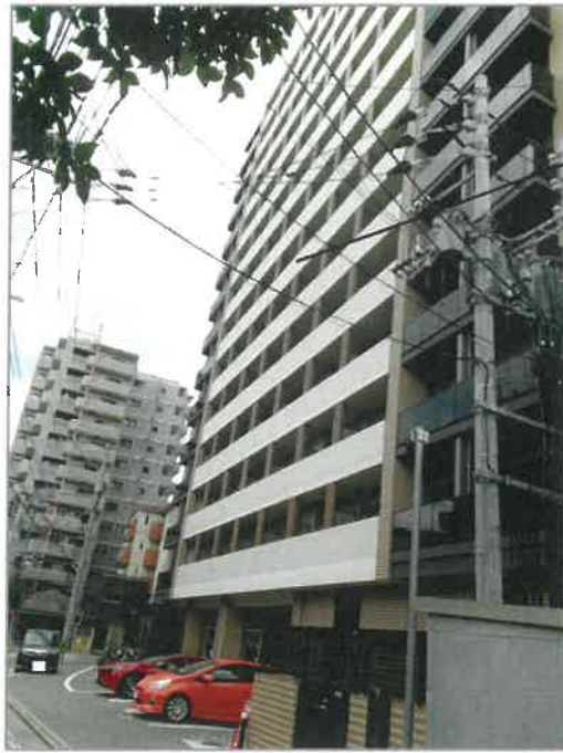
1 目的物件のある 一棟の建物の外観
