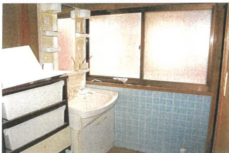
洗面所 (物件3建物)
