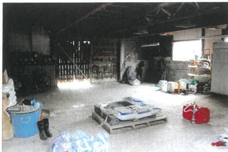
倉庫（物件 2 建物）
