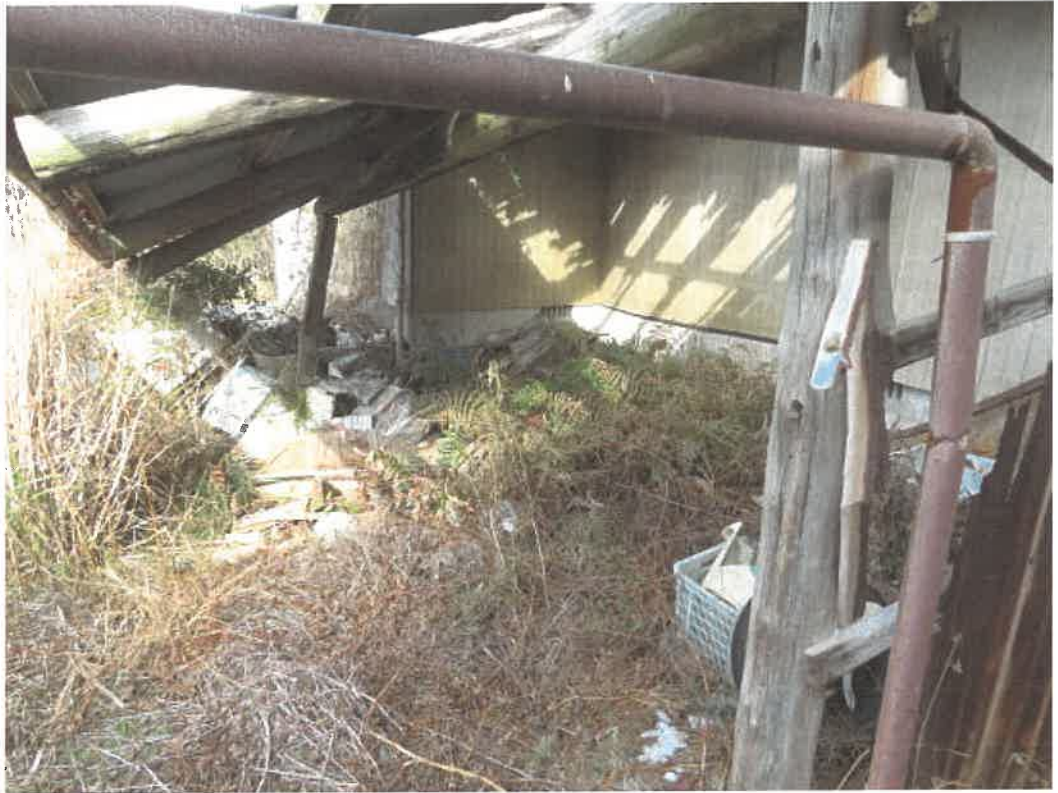
(写真 9) …物件 1 土地西側境界付近
