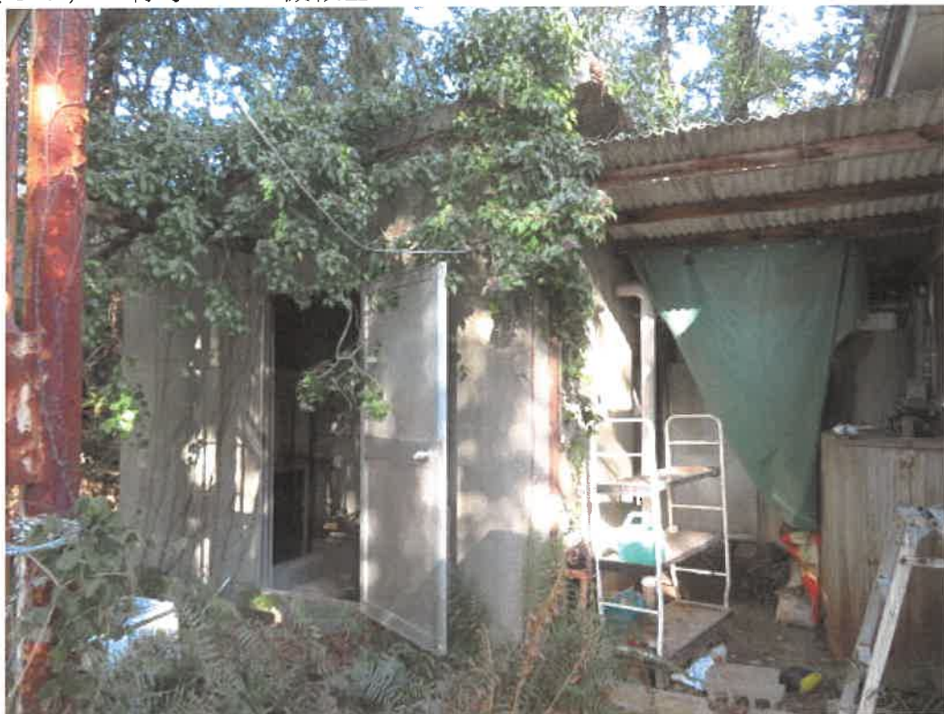
(写真 5 7) …符号 1 1・機械室
