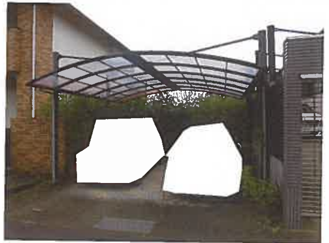
カーポートの設置状況
