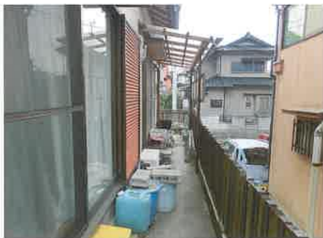
物件 1 南側の状況
