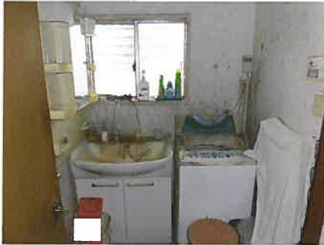
洗面・脱衣室
