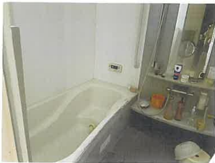
写真⑧建物内部
