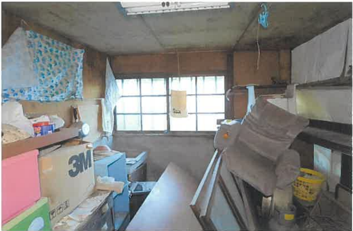
(写真⑨) 本件建物(物件3)の内部
