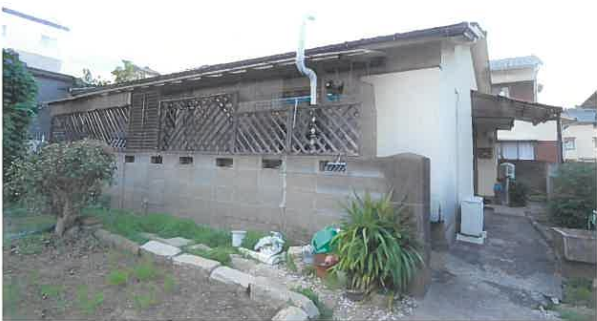
(写真④) 本件土地・建物(物件4)の外景
