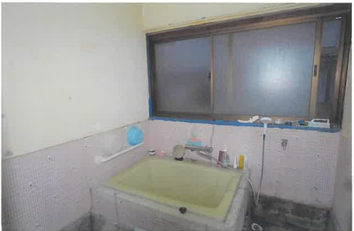
(写真⑭) 本件建物(物件4)の内部
