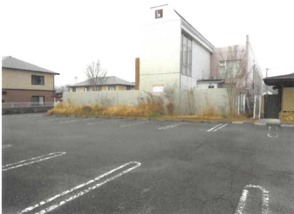
(写真8) 家屋番号665番501の建物
