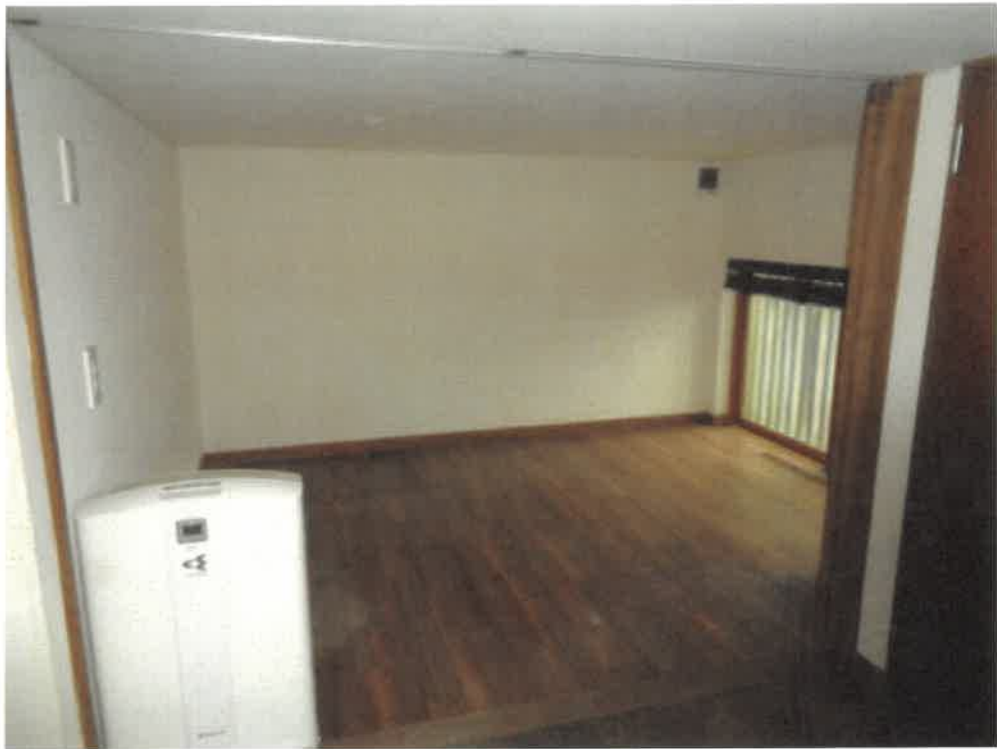
(写真18) 本件建物内部(1階納戸④:登記面積に含まれない)
