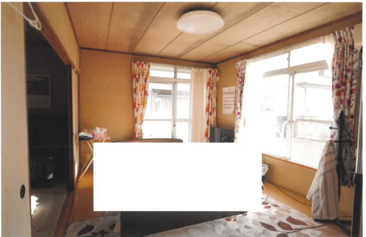
(写真②) 本件建物の内部
