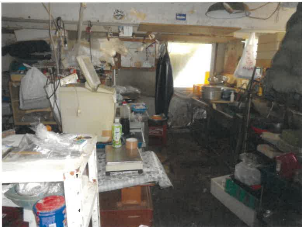
(写真 4) 物件 2 の建物内部 (1 階)
