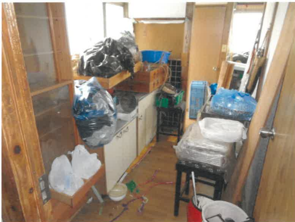
(写真 9) 物件 2 の建物内部 (2 階)
