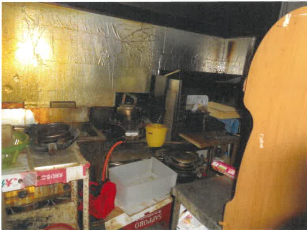
(写真5) 物件2の建物内部(1階)
