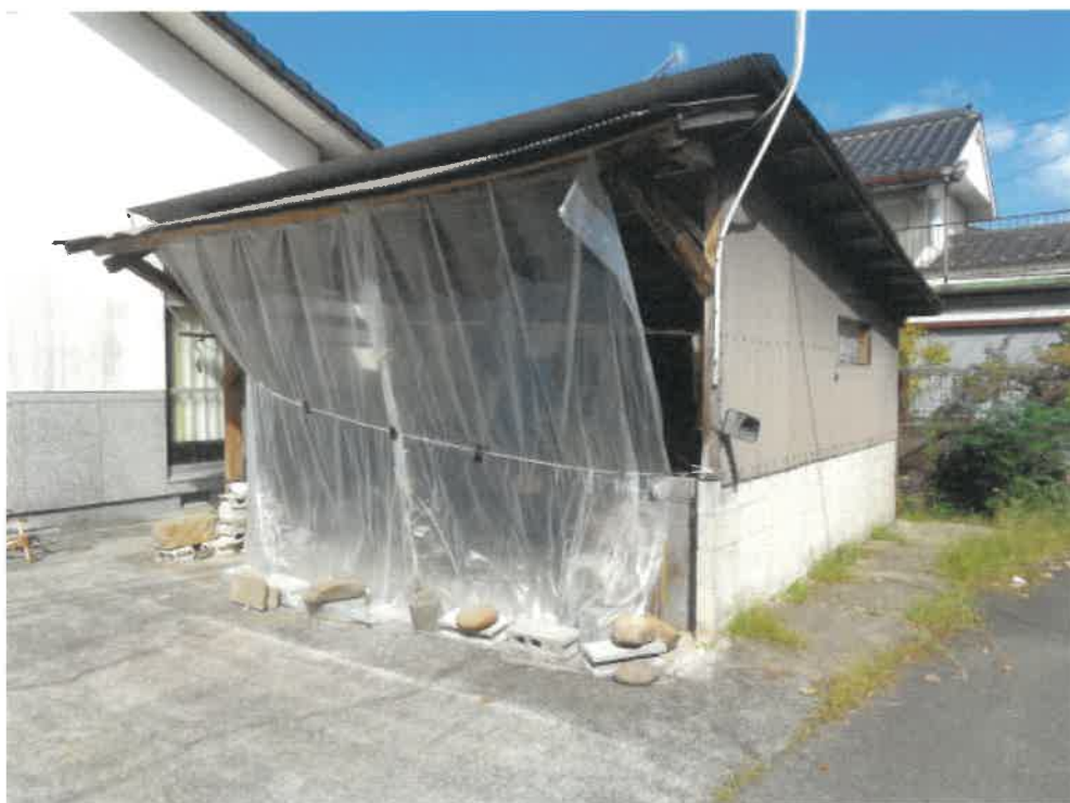
(写真4) 未登記附属建物
