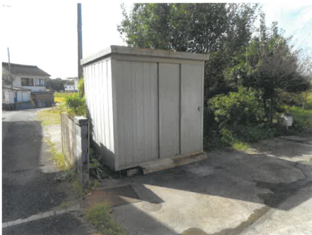
(写真 1 2) Bが所有する売却対象外物件であるスチール製物置
