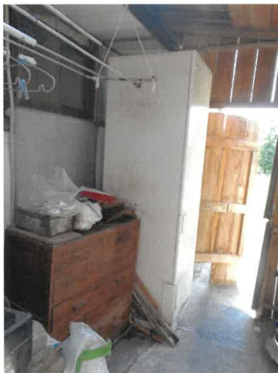
(写真9) 売却対象物件(従物)であるヒートポンプ式給湯器
