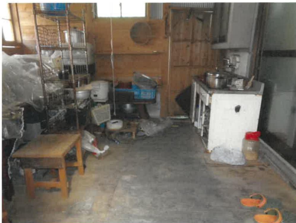
(写真20) 本件建物内部(1階・増築部分)
