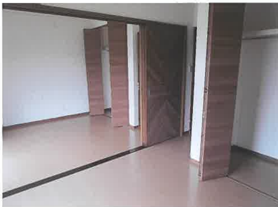
物件5 建物内部
