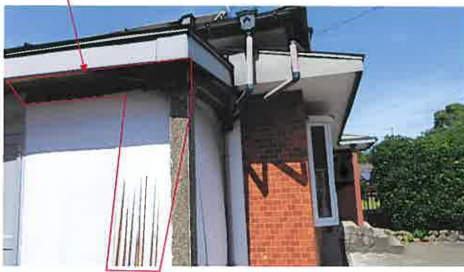
(写真 2 ) 外壁・軒下の損傷
