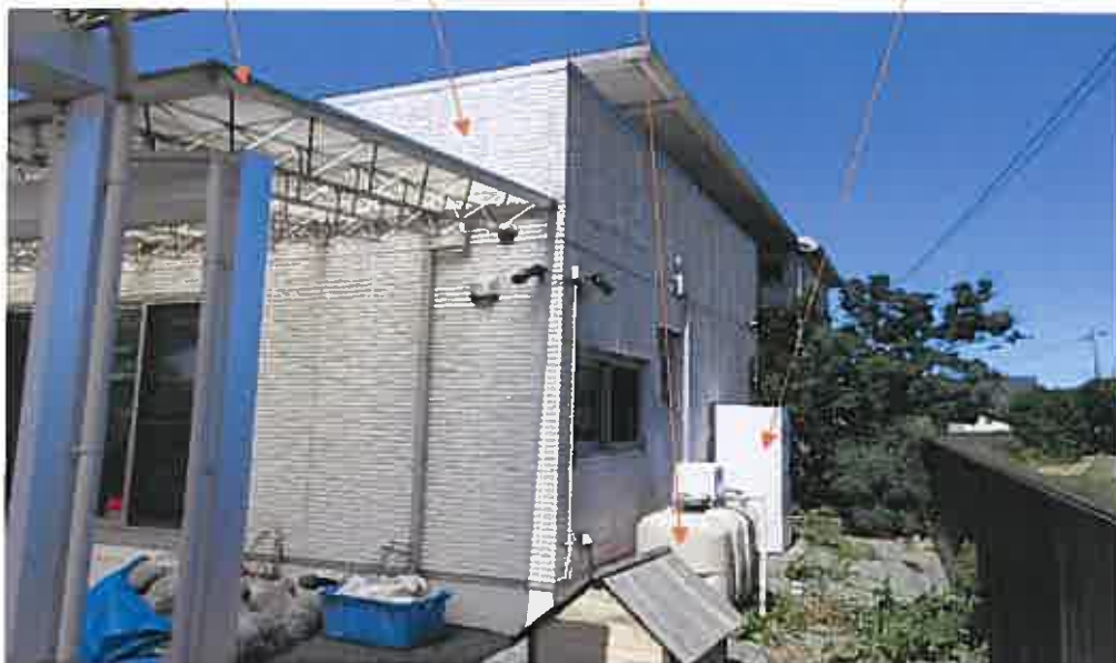
(写真5) 里道 ヒートポンプ給湯機 祠 物件2 下屋 水路
