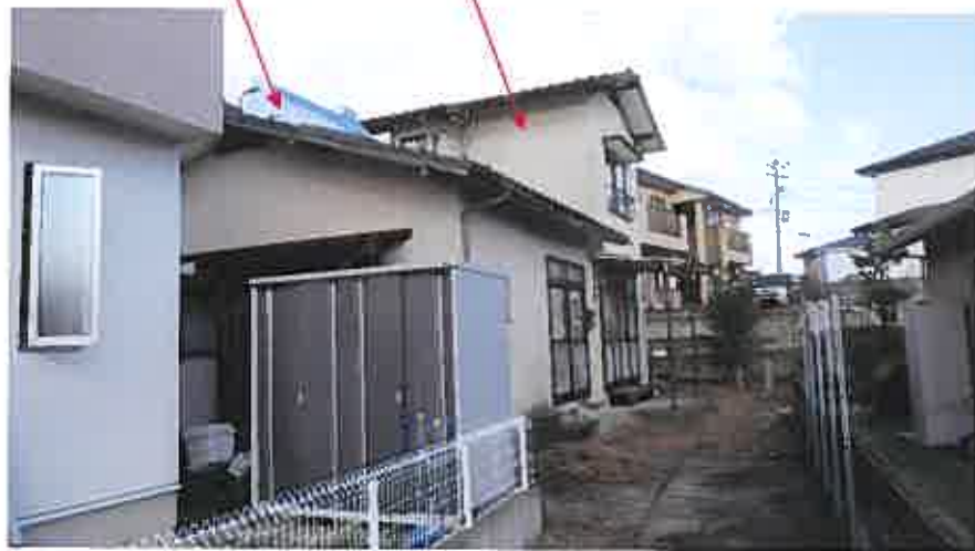
太陽熱温水器 物件 2 (敷地が物件 1)
