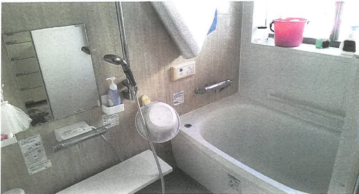
物件2 1階内部状況
