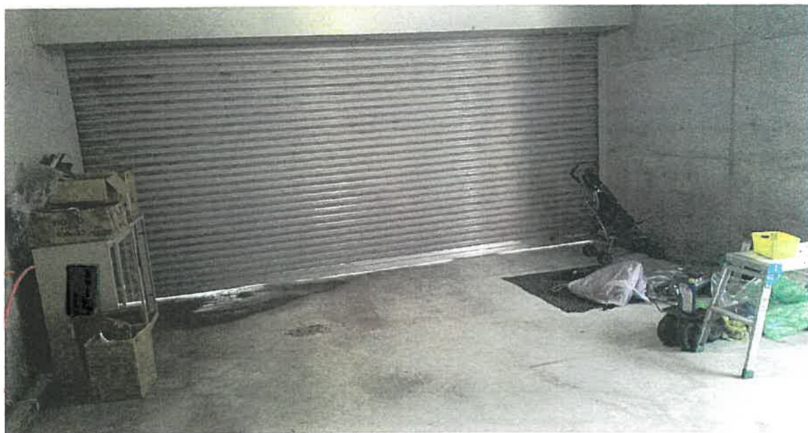
物件 3 内部状況
