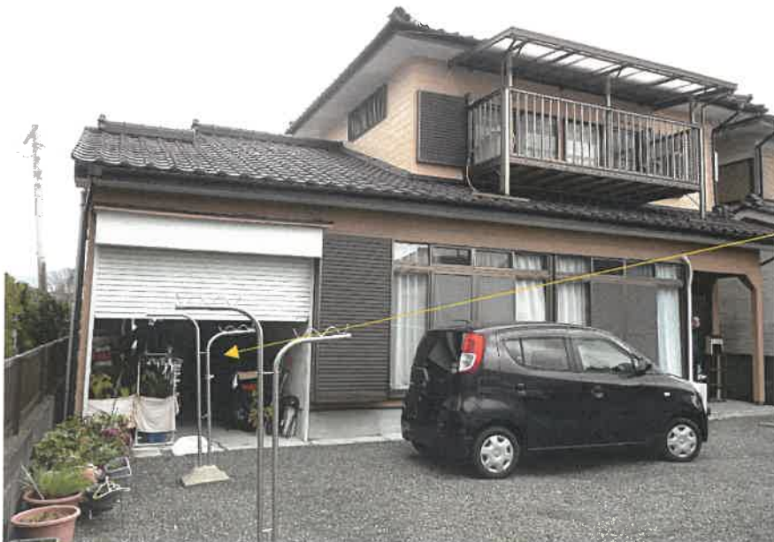
③本建物全景（南西）
