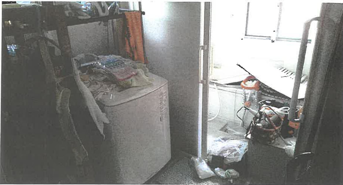
物件 4 1 階内部状況
