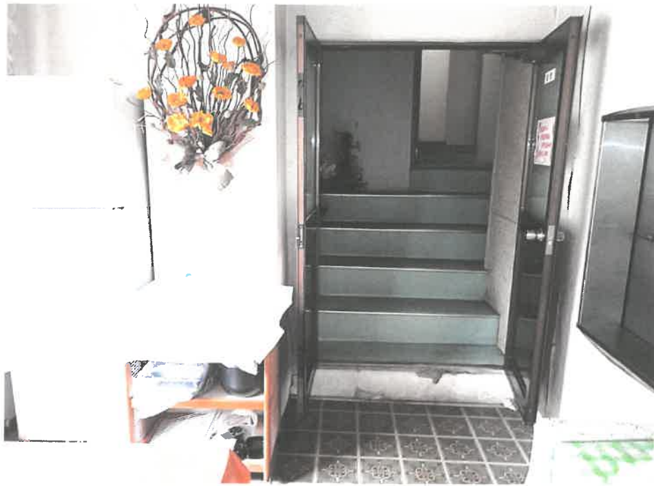
物件4 増築部分（通路階段）
