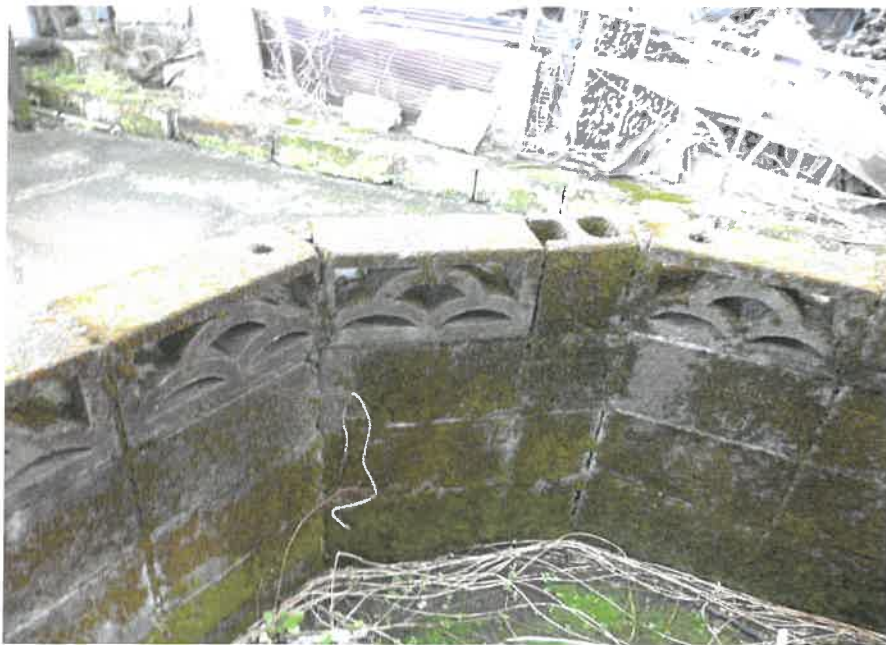
④南東端隅切り部分
