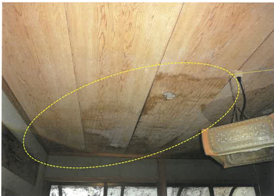
⑨南西方和室天井
