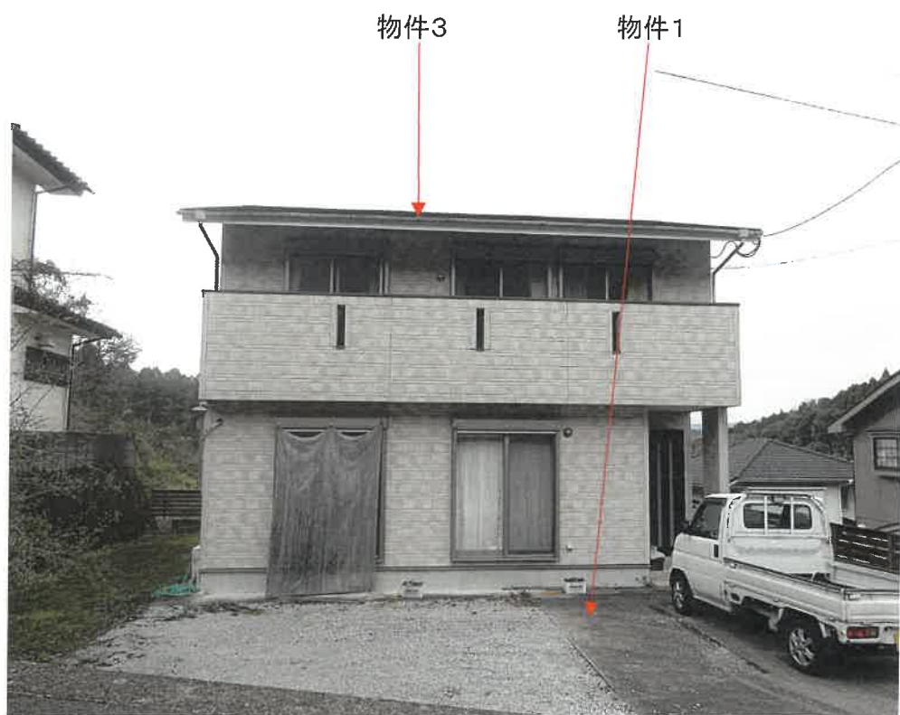
写真1 本件建物外観
