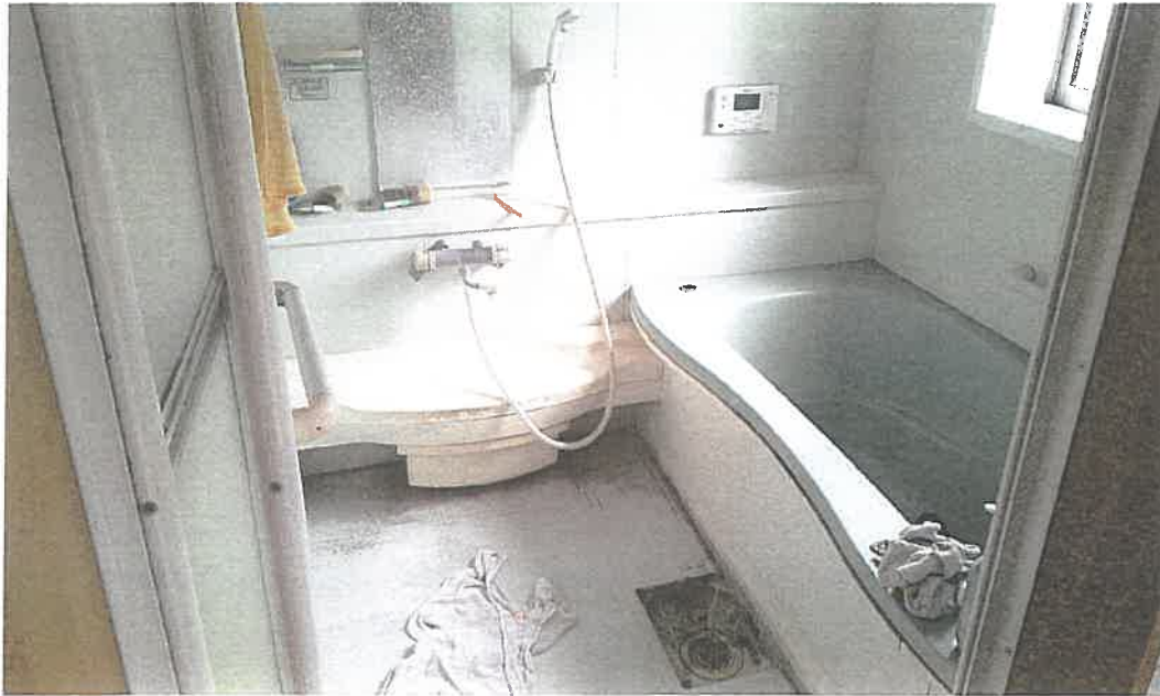
物件 2 1 階内部状況
