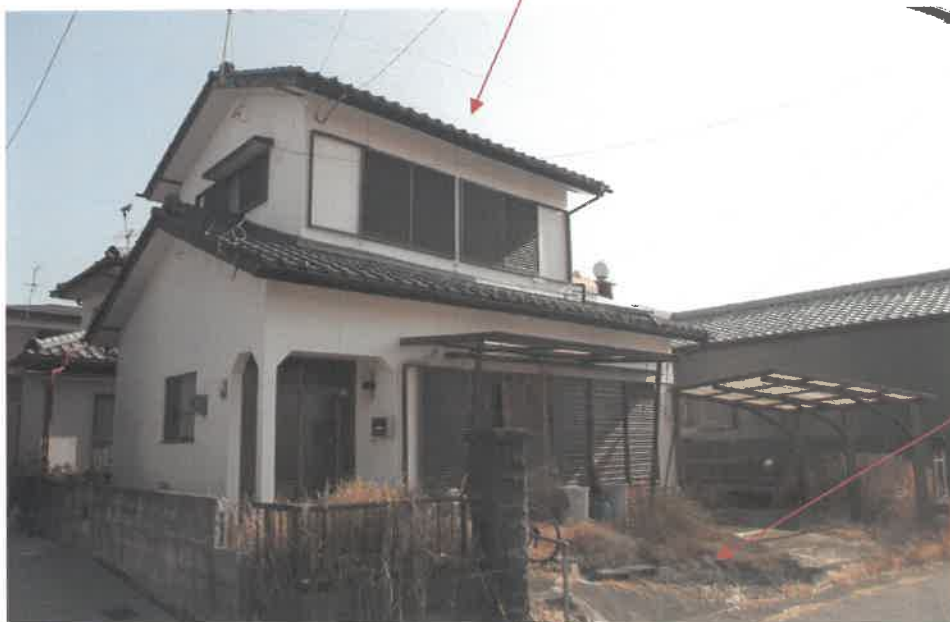
南西方よりのぞむ
