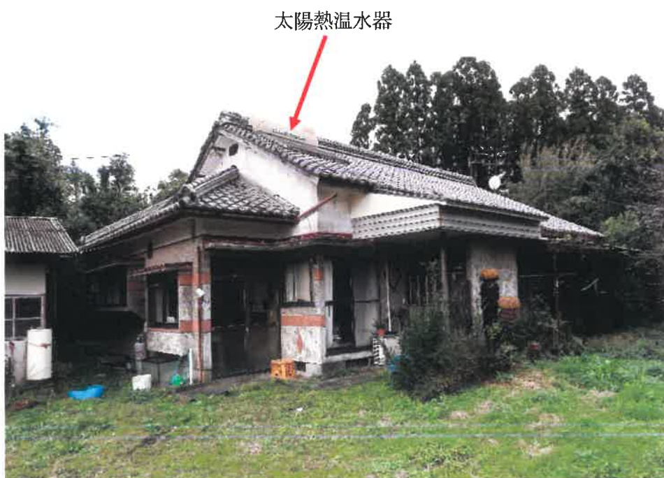
物件6建物（南西側）
