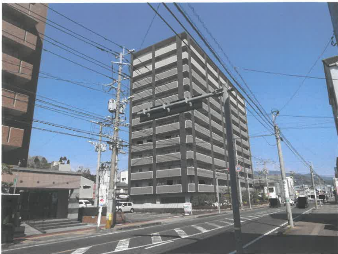
現況写真 南東方から撮影
