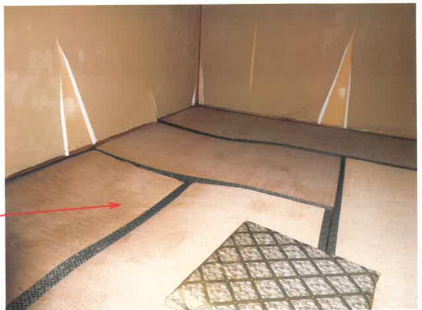
シロアリによる被害箇所
