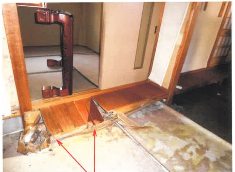
シロアリによる被害箇所
