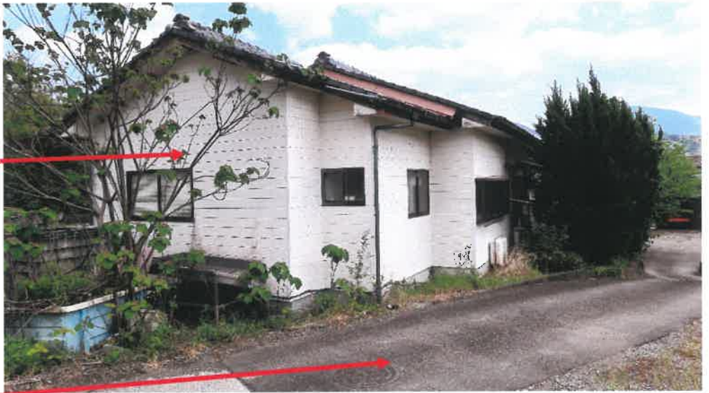
物件 5 建物 (北西側)
