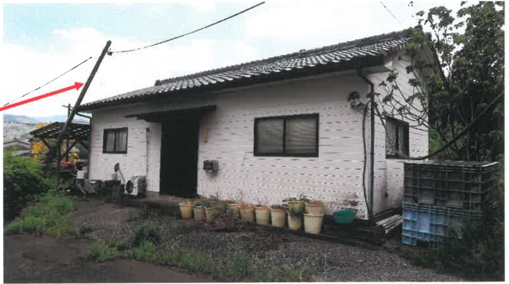
物件 5 建物 (北西側)
