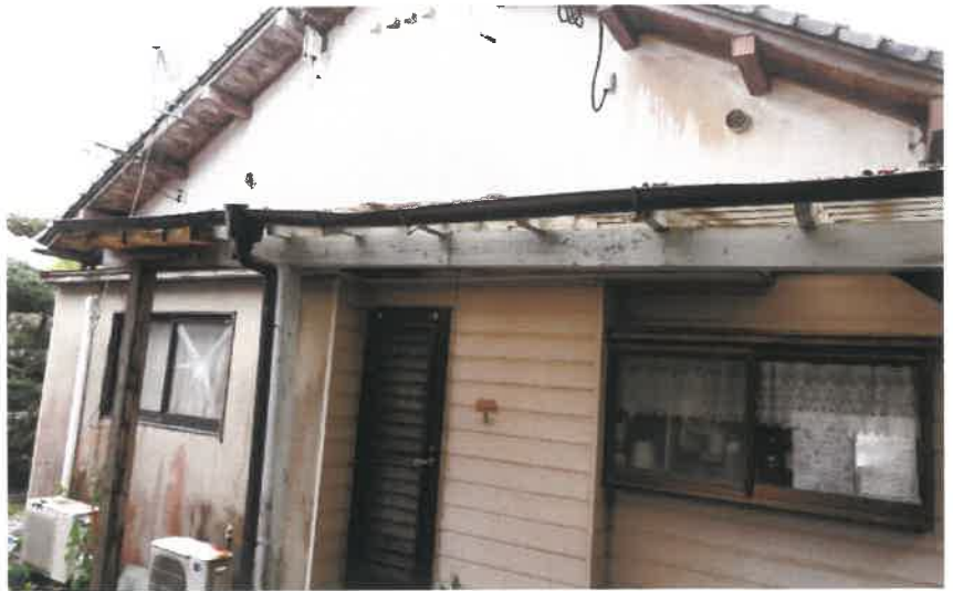
物件 2 建物東側壁面の状況
