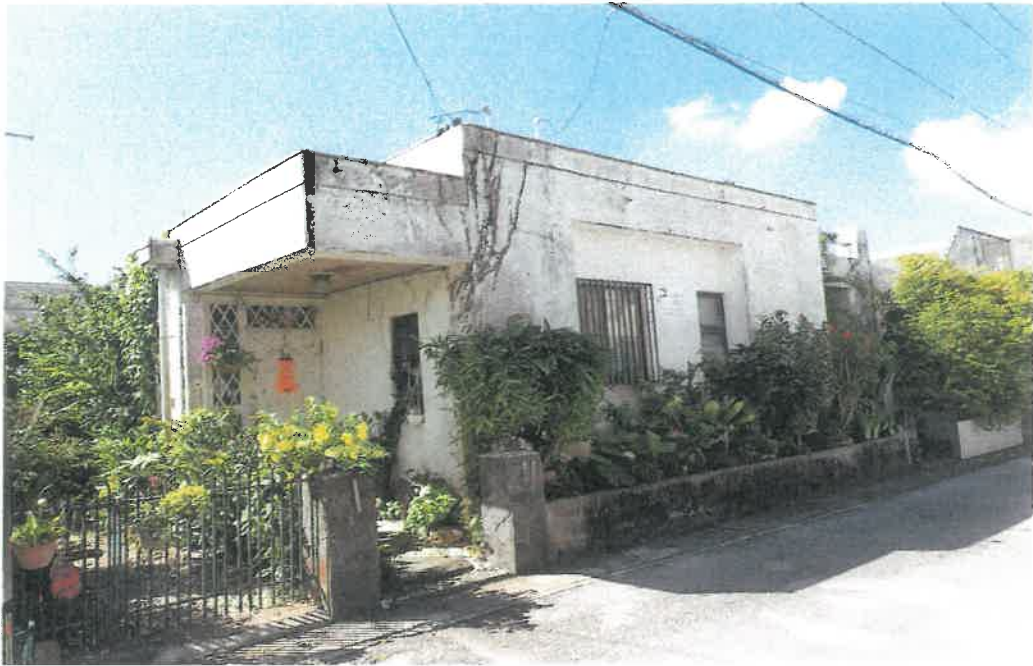
本件建物全景
