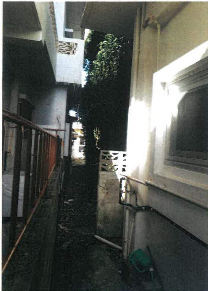
玄関(上部)及び北東側(下部)通路の状況
