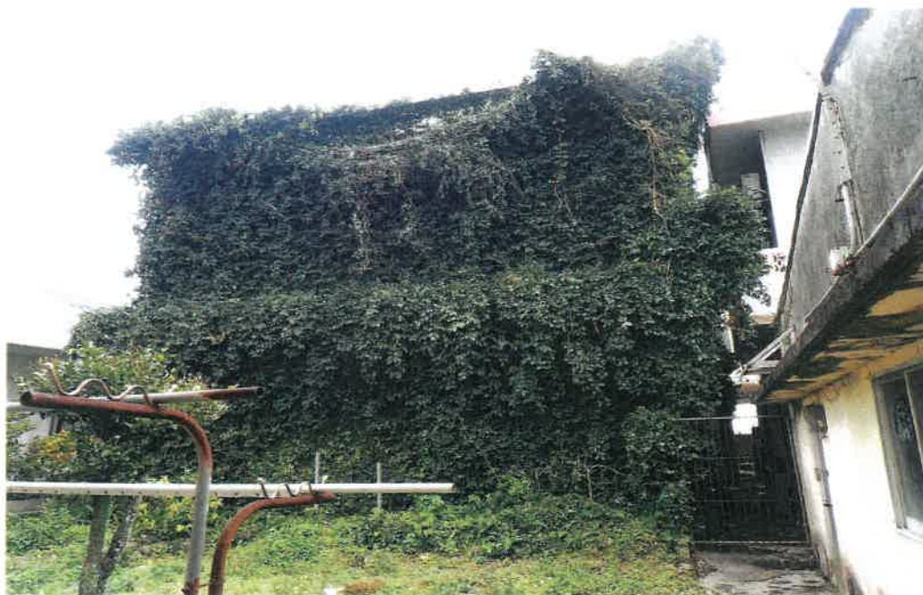
本件建物全景
