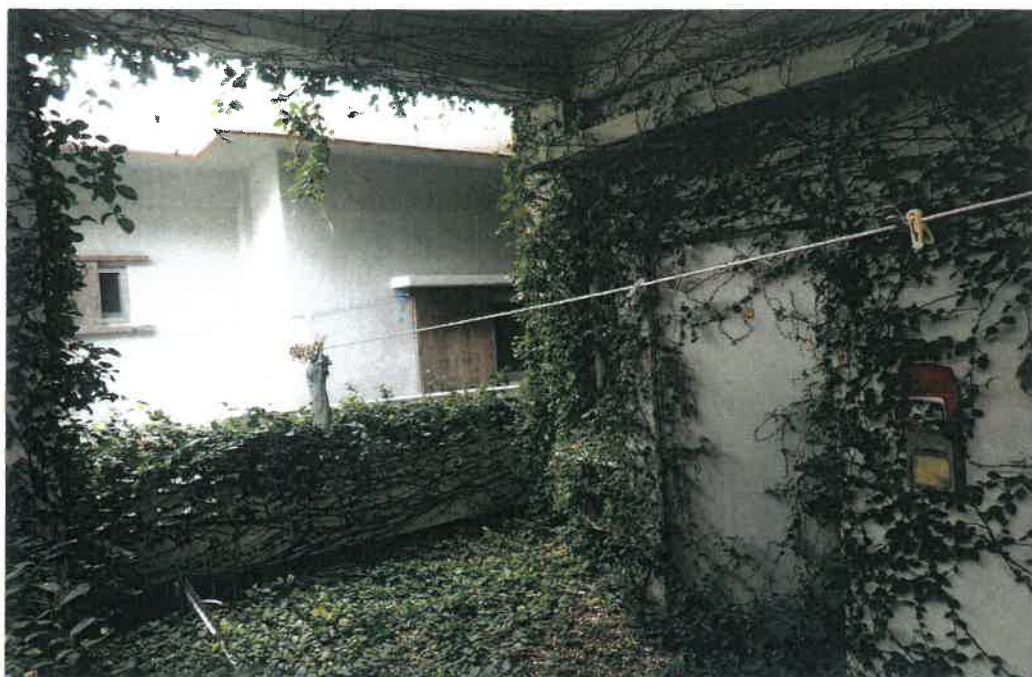
本件建物2階玄関の状況
