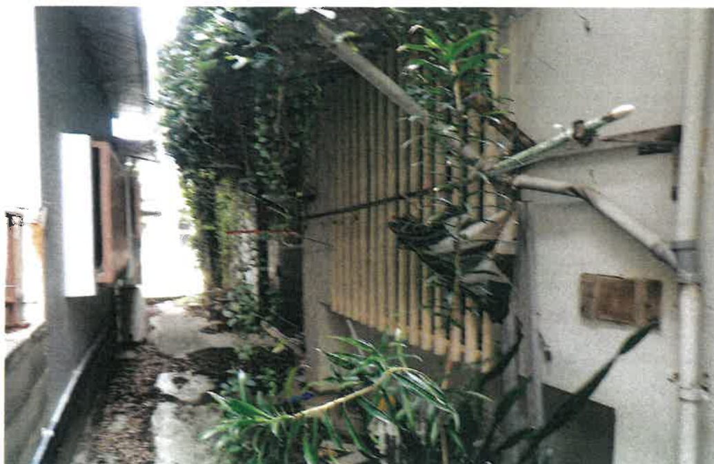
本件建物1階玄関付近の状況
