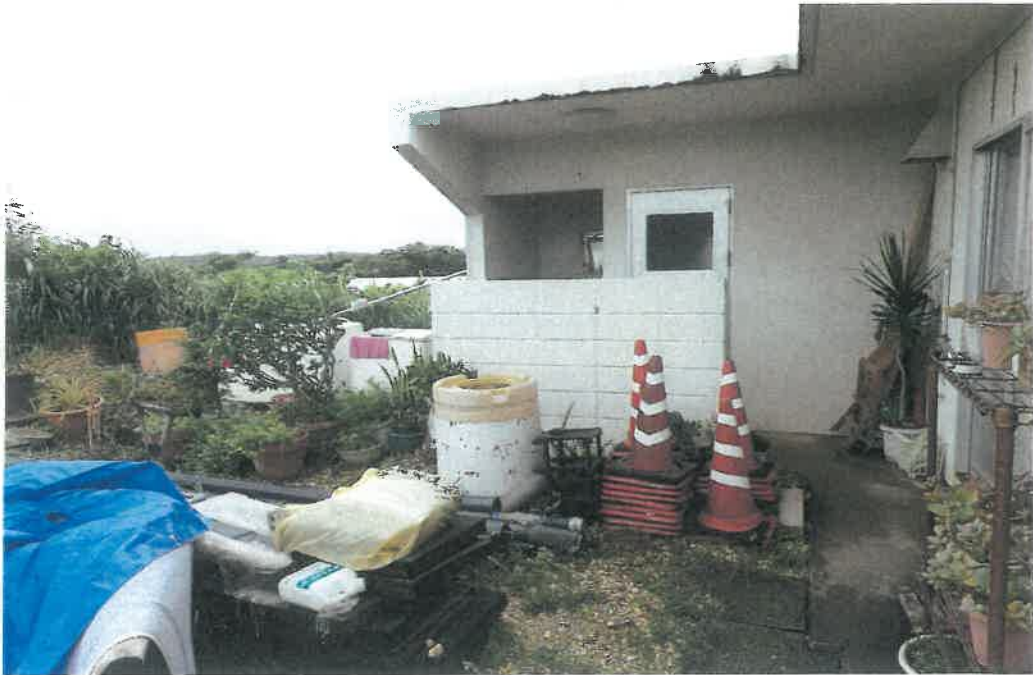
本件建物(トイレ)の状況
