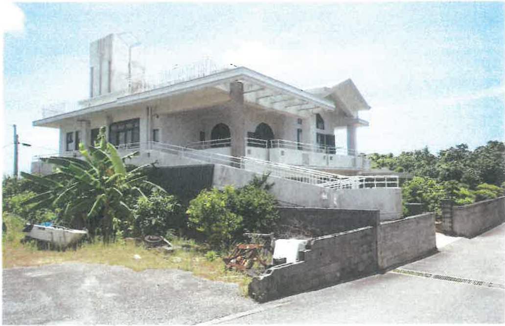
本件建物全景
