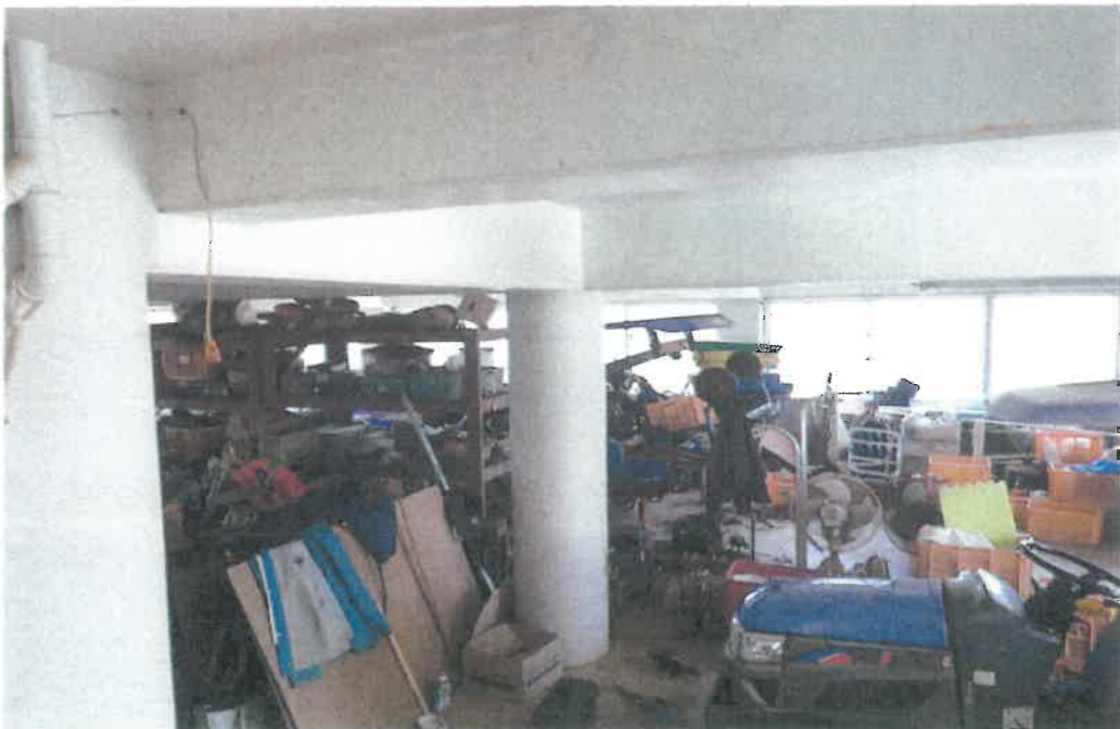
本件建物内部(増築部分)
