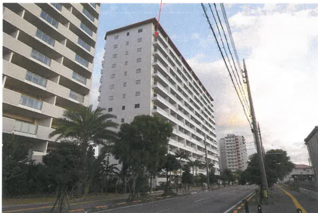
物件1の存する1棟の建物
